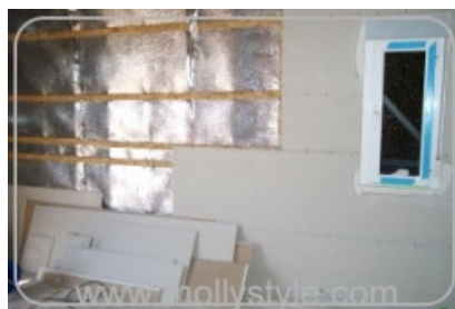
鐵皮/RC 牆壁內隔熱施工
