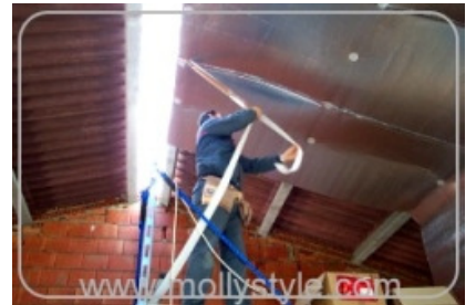
鐵皮屋頂內隔熱施工
