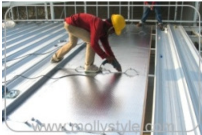
新建鐵皮屋屋頂外隔熱施工
