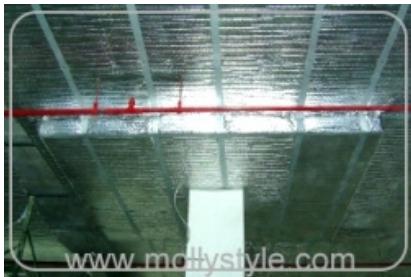
RC屋頂內隔熱施工
