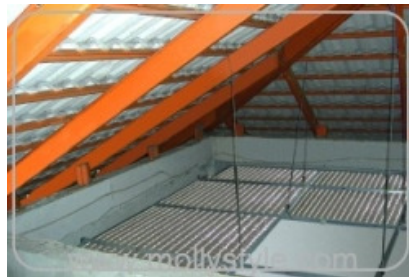
輕鋼架天花板屋頂內隔熱施工
