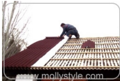
舊建物屋頂翻修隔熱施工
