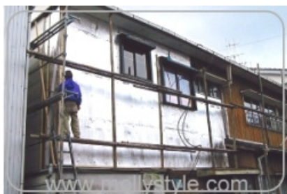
RC外牆隔熱施工
