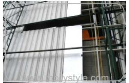
新建鐵皮屋外牆隔熱施工
